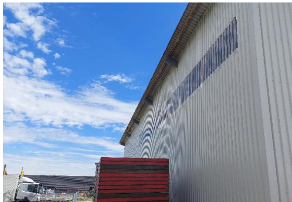
Abbildung 3: Nordseite der abzureißenden Lagerhalle
