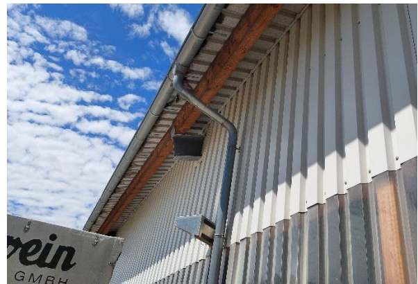
Abbildung 4: Südseite der abzureißenden Lagerhalle
