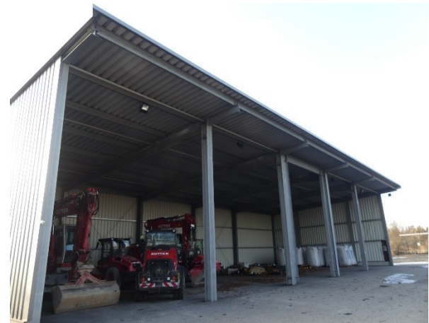
Abbildung 6: Lagerhalle im nord-westlichen auf dem Flurstück 363/1
