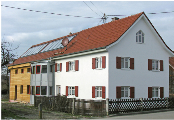
◆ 2012 Tussenhausen, Landkreis Unterallgäu Sanierung Bauernhof mit Ersatzbau für Stadel
